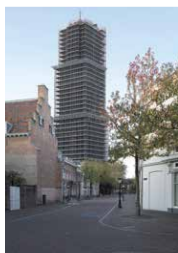
Een steigerjasje voor de toren in 2019. Foto: Luuk Huiskes
